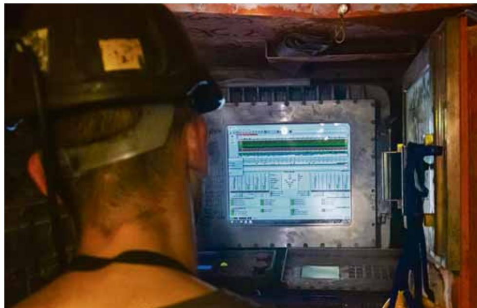
Sterowanie strugiem odbywa się za pomocą pulpitu sterowniczego znajdującego się w chodniku podścianowym
