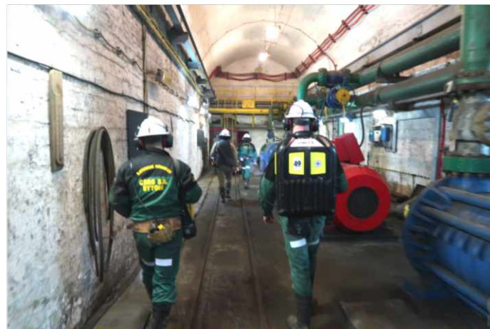
Насосна камера
